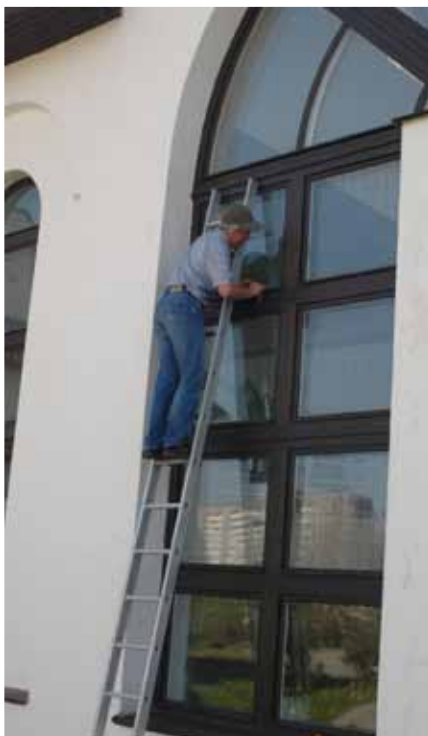
Renovierung der Fenster Foto: privat
